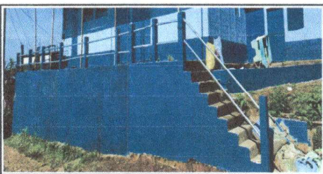
Foto 5: Sustrucción de baranda de metal de pasamanos
