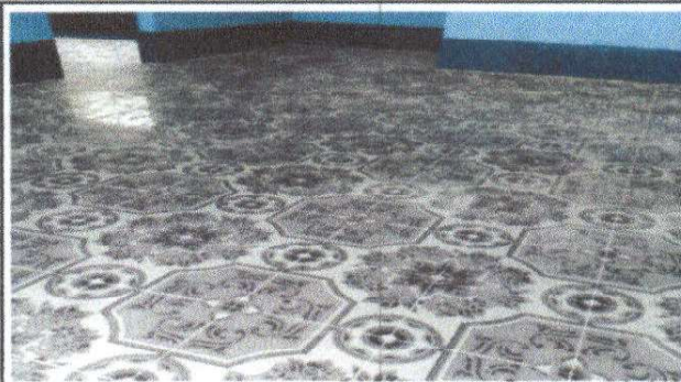
Foto 2: Sustrucción de piso cerámico (modulo de aula)
