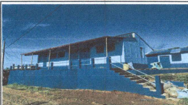
Foto 4: Pintura en muros exteriores (modulo de aula)
